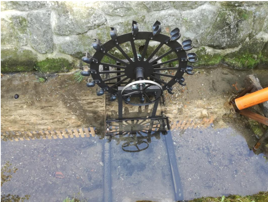
Obr. 24: Upevnění turbíny
