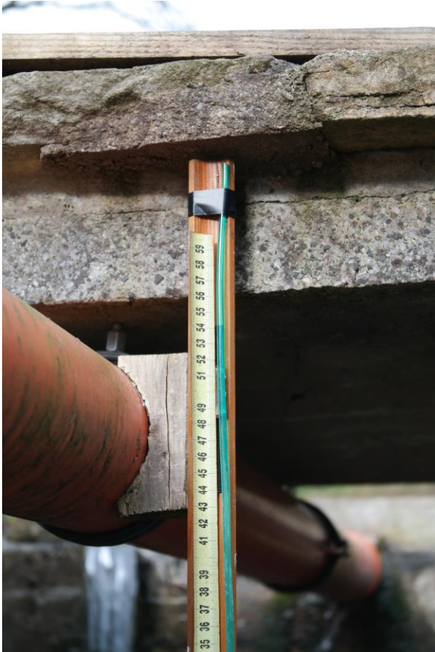
Obr. 27: Měření spádu
