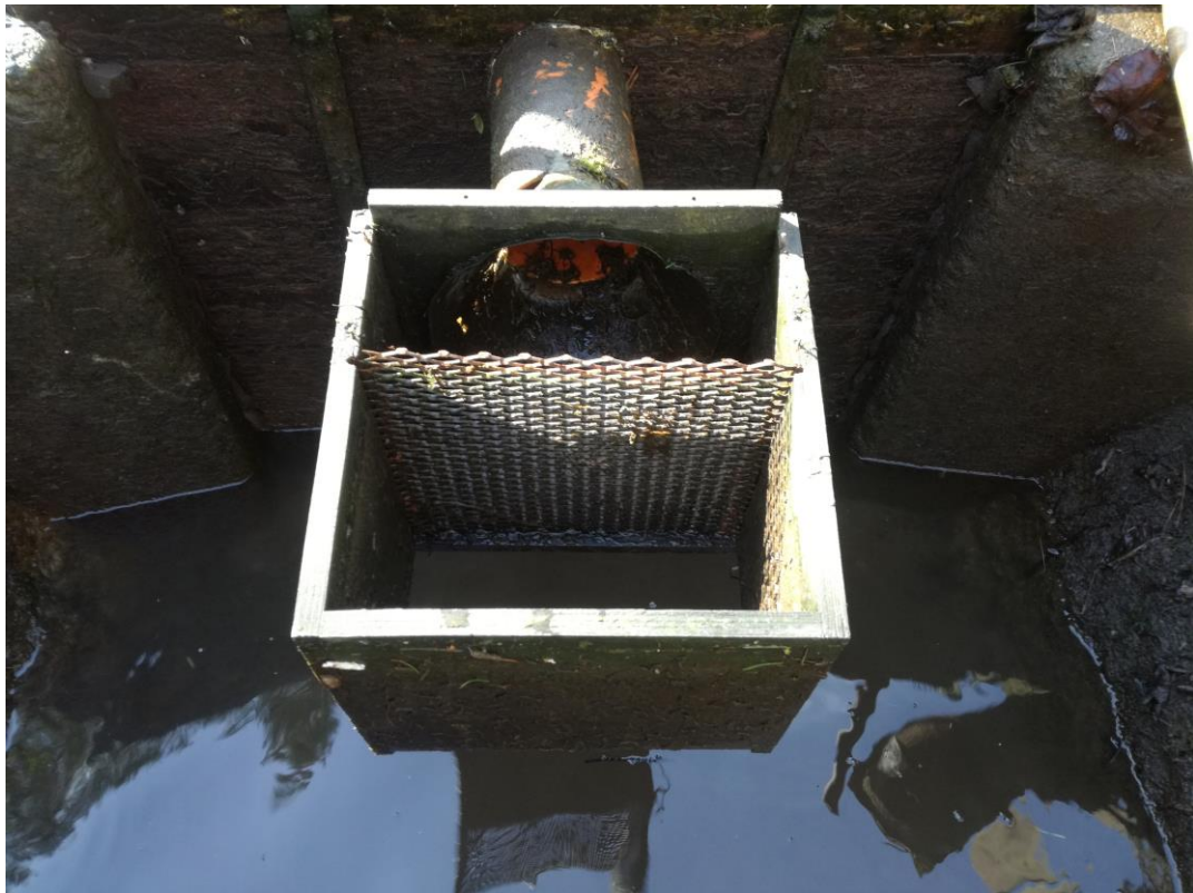
Obr. 26: Česle a vtok do potrubí
