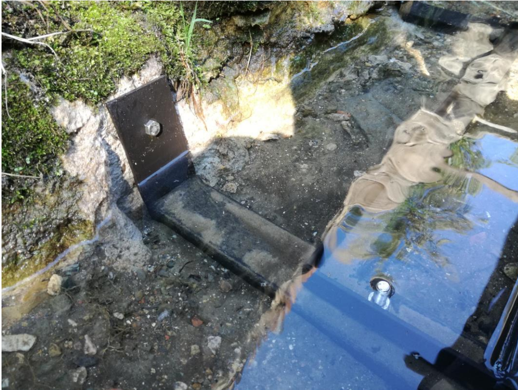
Obr. 23: Detail upevnění stojanu turbíny a přepažení
