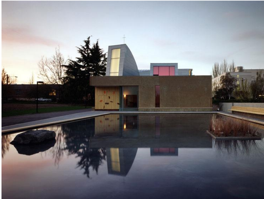
Obr. 13: Kaple svatého Ignáce
