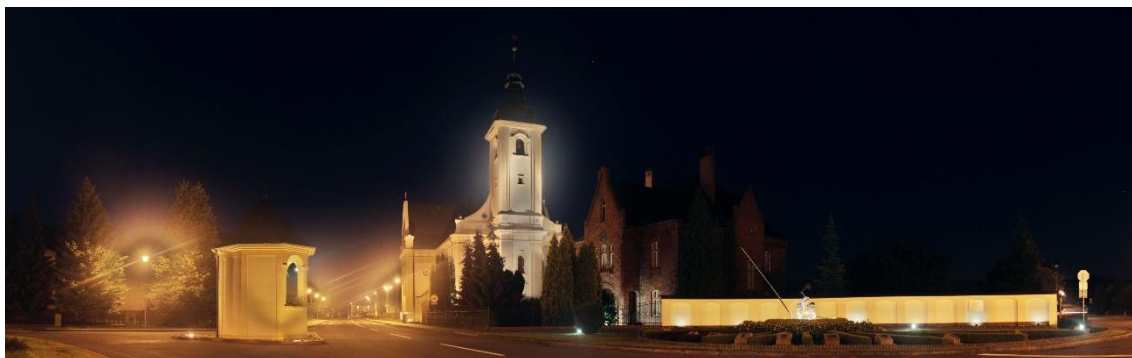
Obr. 19 - Osvětlení Kostela sv. Vavřince v Píšti
