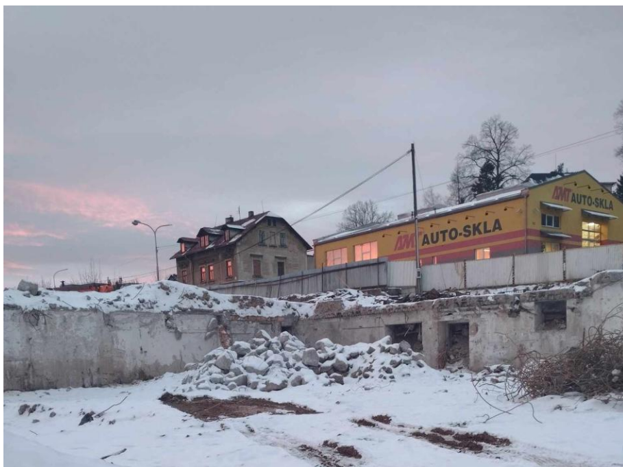
Obrázek 46 Pozůstatky po původní budově LITESU, zbořena přibližně před rokem, leden 2025
