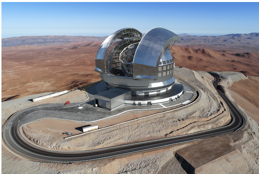
Obrázek 6: Vizualizace budovaného dalekohledu ELT po dokončení na hoře Cerro Armazones v Chile. Převzato z [14].
