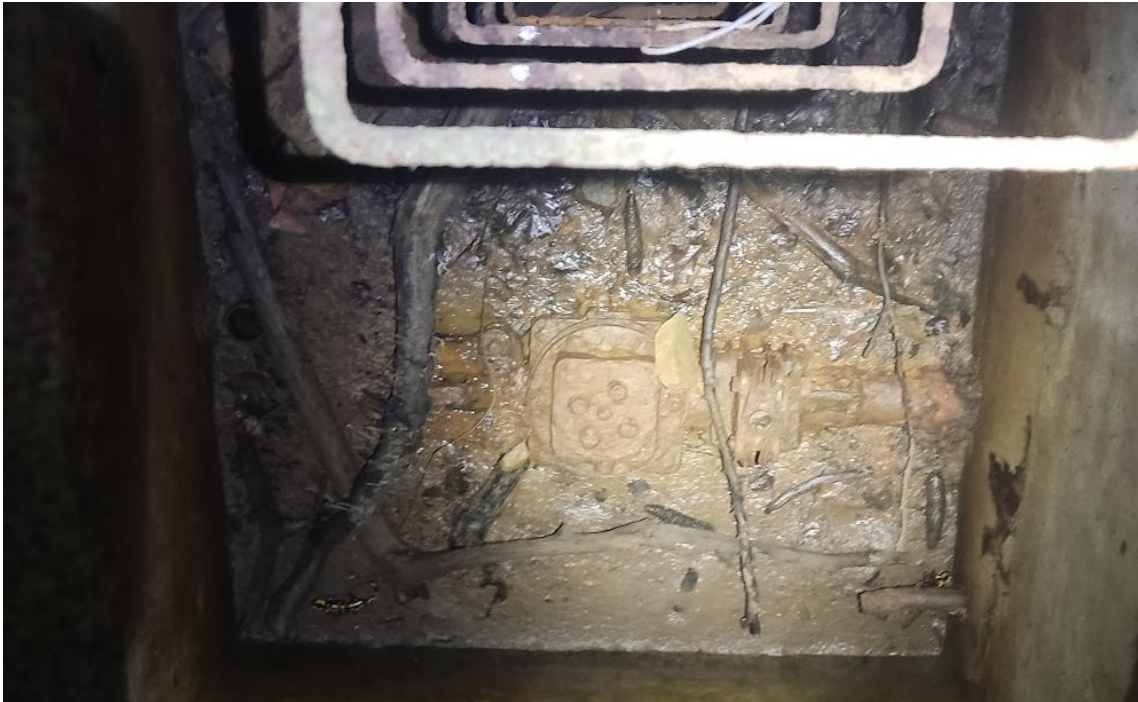
Příloha č. 16. interiér z objektu na levém břehu Lukovského potoka (příloha č. 15). Je zde zachován zbytek trkače.
