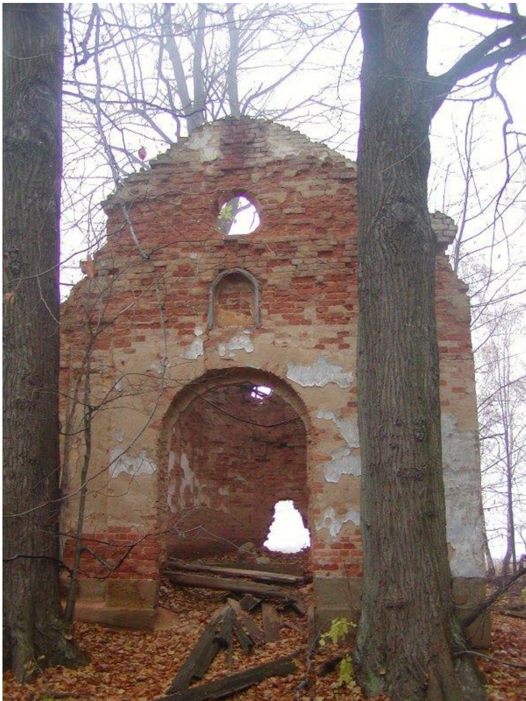
Příloha č. 11. Průčelí kaple v roce 2005
