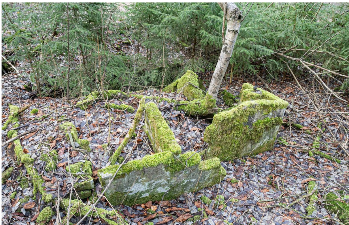
Příloha č. 21. Základy domu čp. 22.
