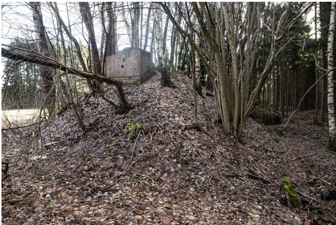
Příloha č. 14. Pozůstatky vodovodu jsou jedna z mála staveb, která se v Královci dochovala.
