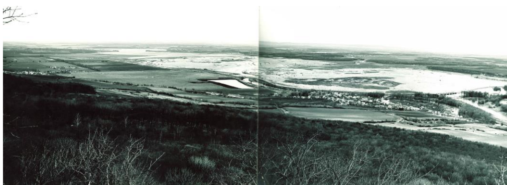
Obrázek 1: Výstavba Střední nádrže, archiv Povodí Moravy, s.p., 1980
