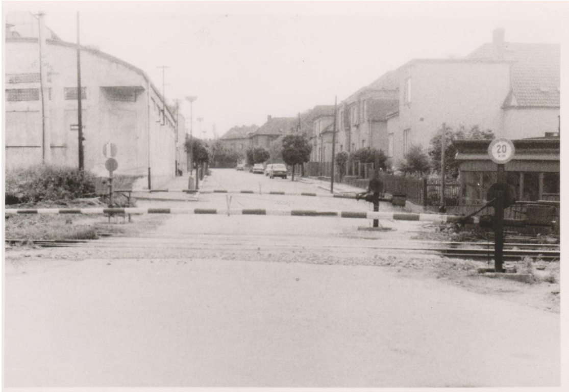
Obrázek 27: přejezd P3717 v ulici Chotusická s mechanickými závorami, tedy před rokem 1984, nalevo závorářské pracoviště (foto Pavel Miškovský)
