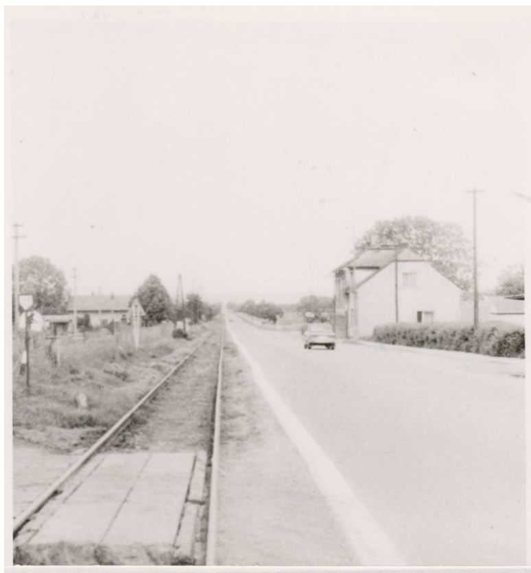
Obrázek 25: souběh tratě 236 a silnice I/17, rok 1985, nadjezd obchvatu samozřejmě chybí (foto Pavel Miškovský)
