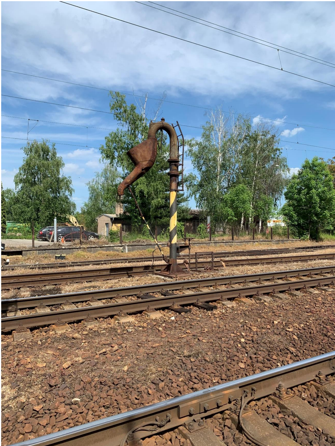
Obrázek 18: nepoužívaný vodná jeřáb pro parní lokomotivy (foto autora)
