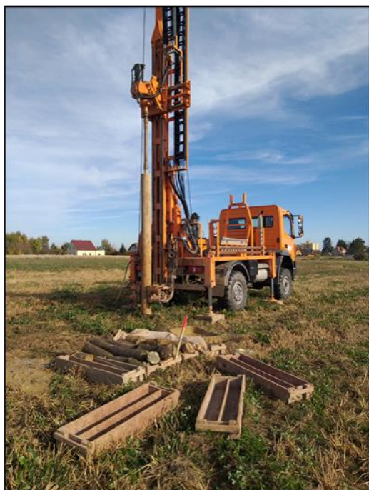
hydraulická vrtná souprava na automobilovém podvozku, Třeboň – vrt
