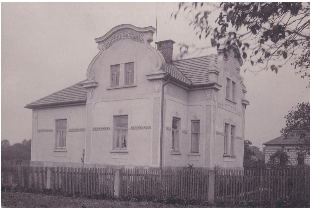
Obrázek 9 – Vila č. p. 150 v Lázních Bělohradě, asi 1912, východní strana
