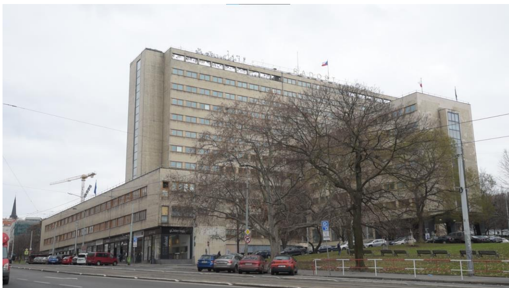
Obr. 5: Bývalý Dům odborových svazů, dnes nesoucí název Dům Radost. Zdroj: archiv autora.
