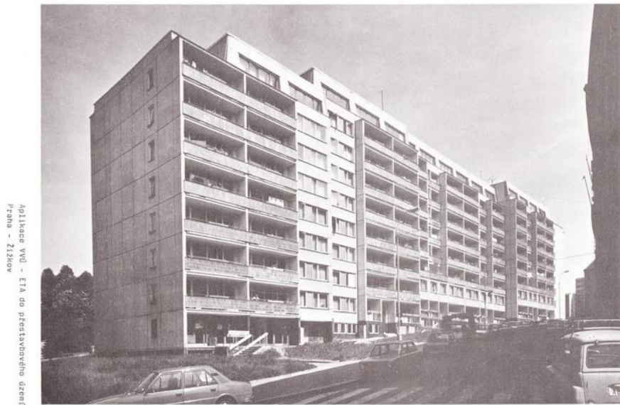
Obr. 3: Panelový dům soustavy VVÚ ETA postavený v rámci žižkovské asanace, Lupáčova ulice. Zdroj: Zdeněk Kuna, Proměny české architektury , Praha 1987.
