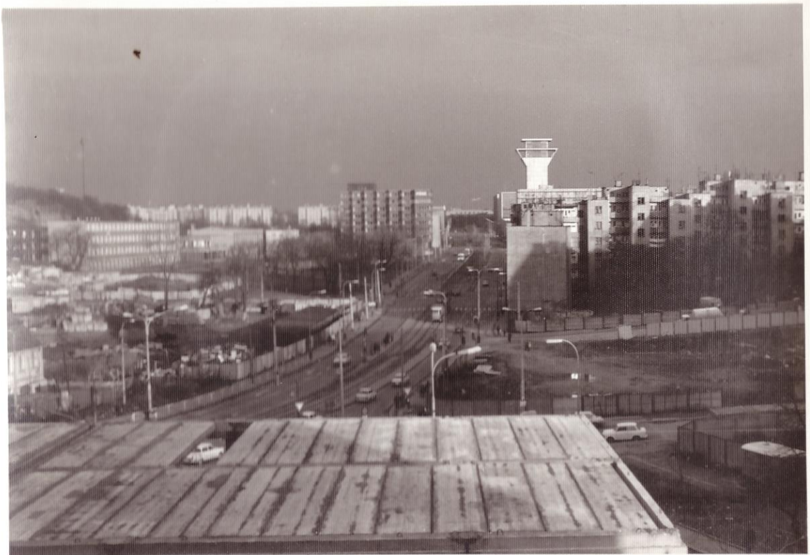
Obr. 13: Pohled z panelového domu v Kubelíkově ulici, výhled do Olšanské ulice. Dole nová Bezovka, nalevo prázdná parcela před vystavěním hotelu Olšanka, napravo rovněž zatím bez zástavby dalším panelovým domem. Zdroj: archiv autora.
