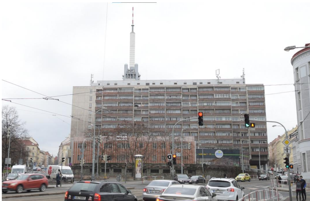
Obr. 14: Aktuální stav, Pohled na panelový dům v Kubelíkově ulici (č. p. 703, 717, 725 a 733) z Olšanského náměstí, aktuální stav. V popředí Bezovka a obchodní jednotka. Zdroj: archiv autora.
