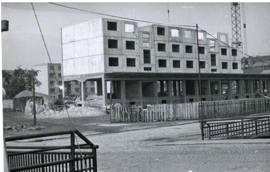
Obrázek 42: Panelová výstavba ve střední části ulice, první polovina 60. let, Zdroj: soukromá sbírka Roberta Kleina
