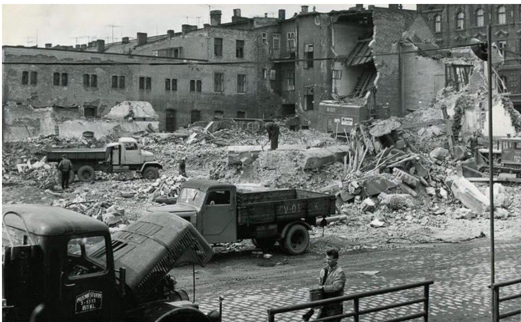
Obrázek 41: Demolice střední části ulice v roce 1961, Zdroj: soukromá sbírka Roberta Kleina
