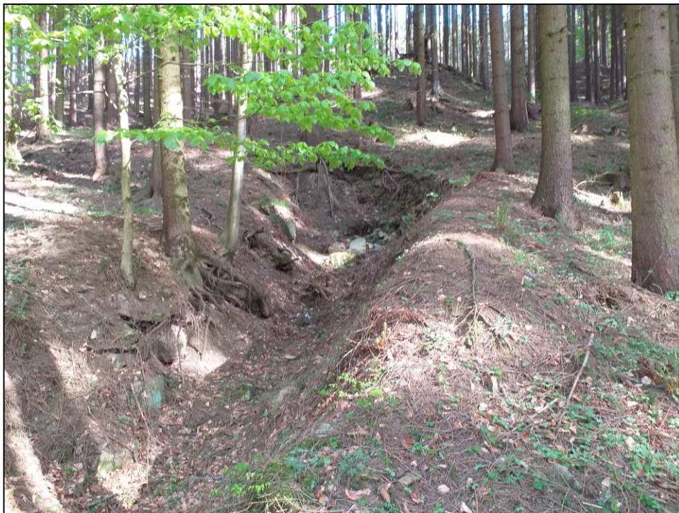
Příloha 5: Pohled na zářez a bývalé ústí štoly Václav. Snímek pořízen 2. 5. 2020, ještě před zahájením kácení lesního porostu na lokalitě Havírna. Foto: K. Pročka
