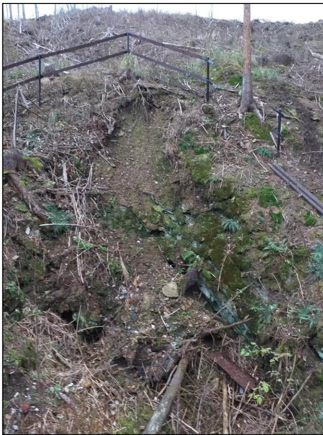
Obrázek 2: Detail stěny poškozeného propadu s výrazným objemem utržené horniny. Foto: K. Pročka, 2020
