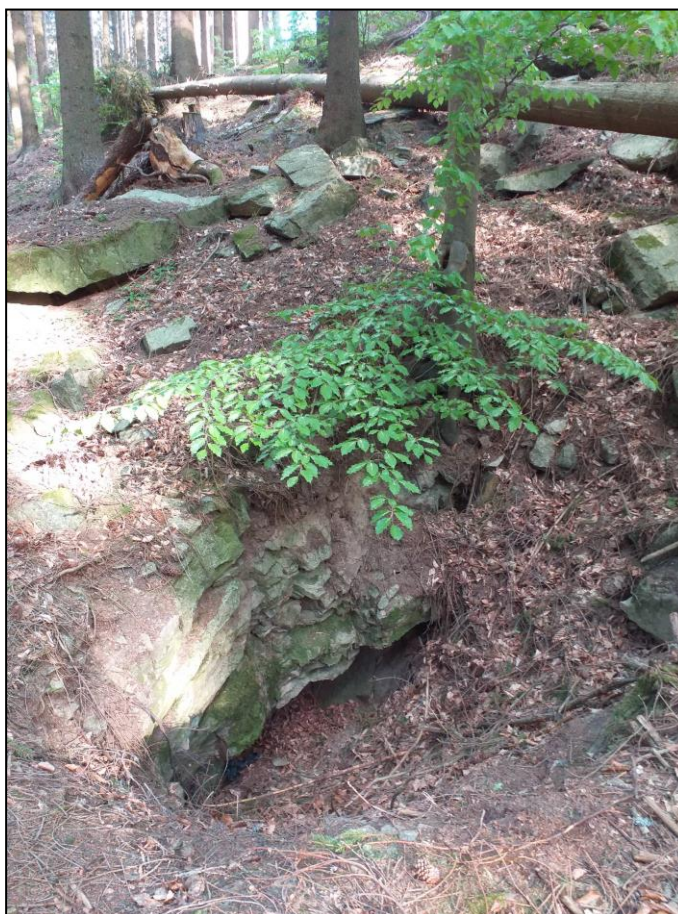
Příloha 8: Propad středověké šachtice na severním obvalovém tahu na lokalitě Havírna. Zajímavá je viditelná přítomnost skalního tělesa, ve kterém byla šachtice zaražena. Foto: K. Pročka, 2020
