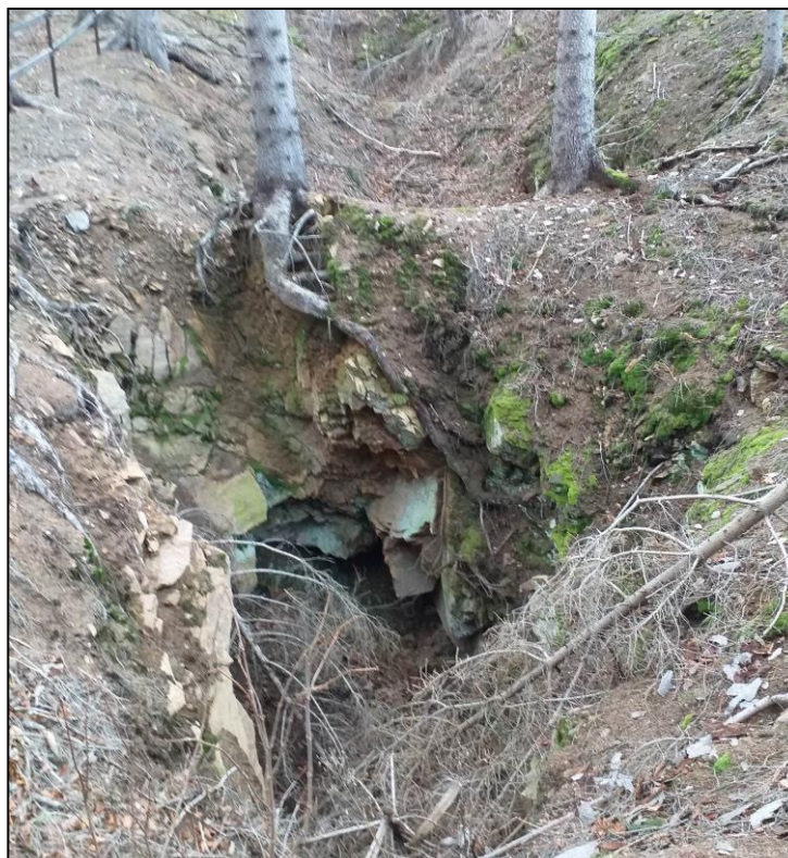
Obrázek 4: Detail poškozeného celíku mezi dobývkami na lokalitě Havírna. Foto: K. Pročka, 2020
