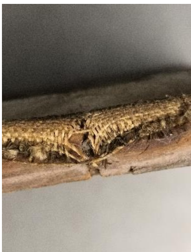
21. Detail špatně zatlučeného čal. hřebíku (autorka práce)
