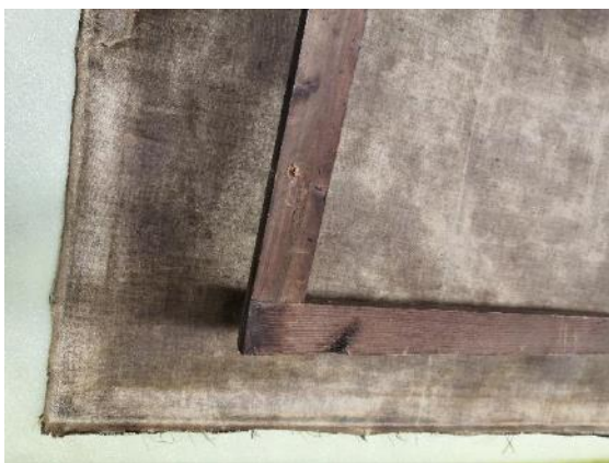
25. Napínací rám před restaurováním
