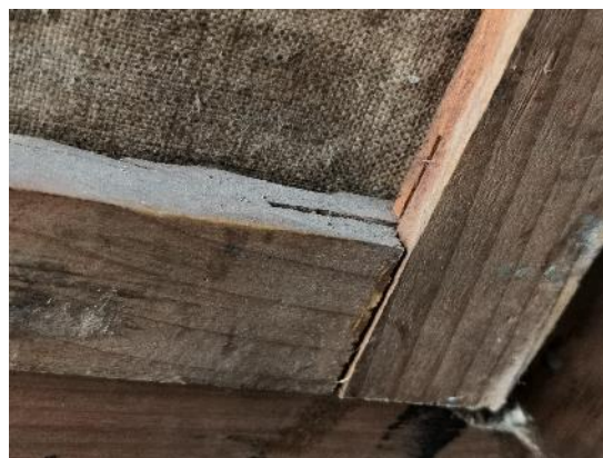
17. Původní spoje na tupu (autorka práce)
