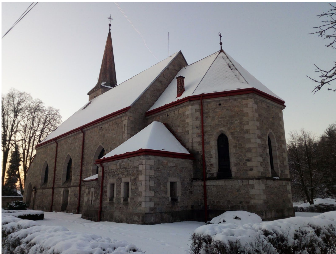
27. Celkový pohled na kostel z Tyršovy ulice v zimě
