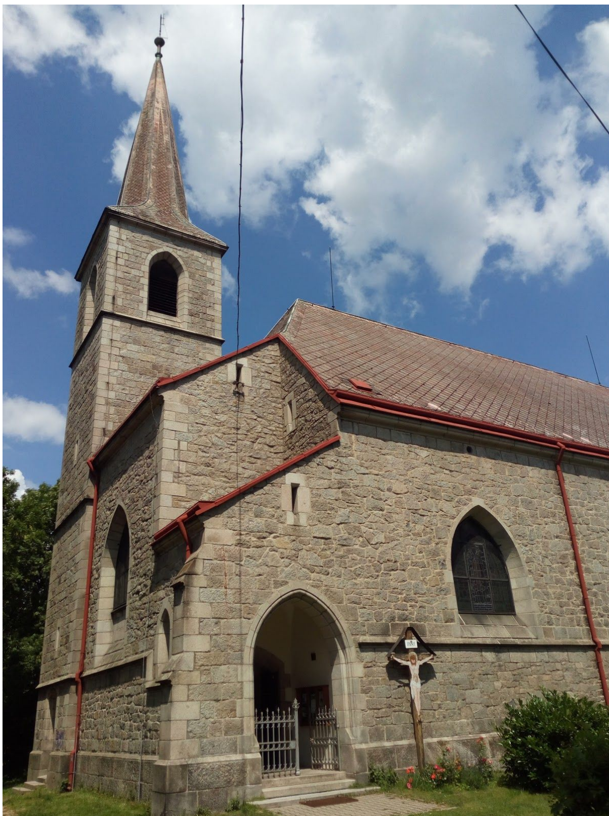
24. Portál kostela, v pravé části kříž s ukřižovaným Ježíšem Kristem
