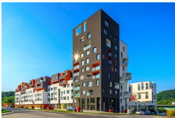
Obrázek 12: Jeden z bytových domů v komplexu
