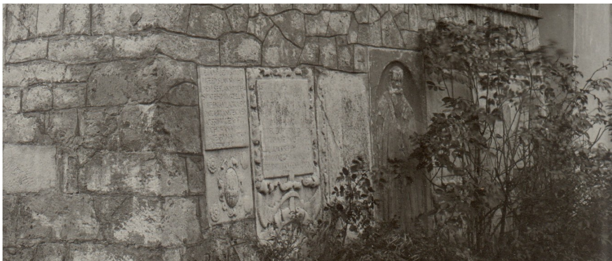
Obrázek č. 9: Severní strana zvonice s vyzděnými náhrobky. 50
