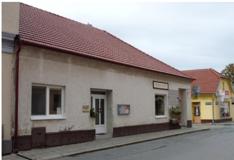
Obrázek č. 19: Dům č. p. 34, současný stav.
