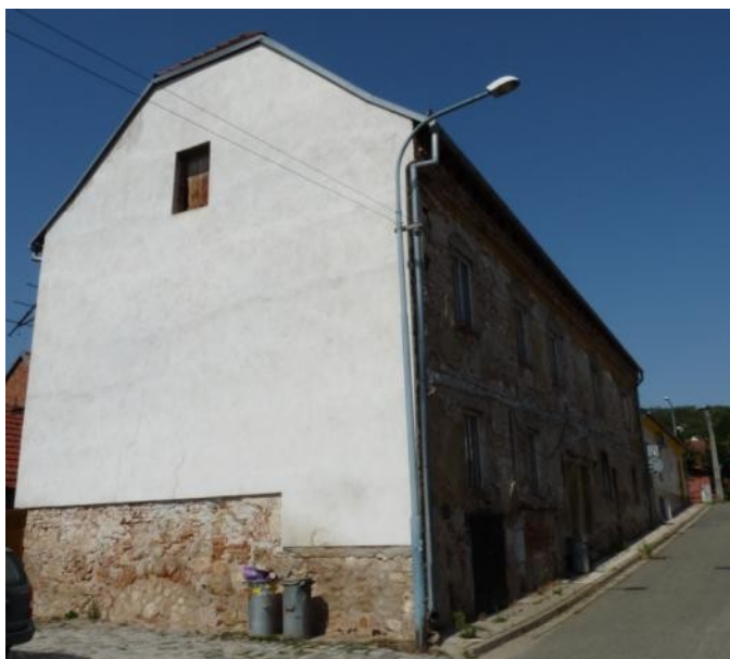
Obrázek č. 14: Dům č. p. 32, současný stav.
