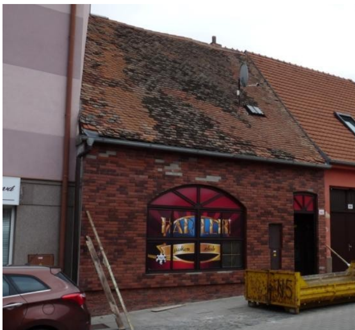
Obrázek č. 83: Dům č. p. 352, současný stav.
