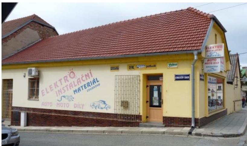
Obrázek č. 89: Dům č. p. 408, současný stav.
