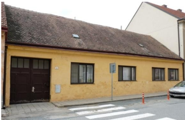
Obrázek č. 26: Dům č. p. 36, současný stav.
