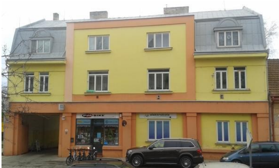
Obrázek č. 36: Dům č. p. 38, současný stav.
