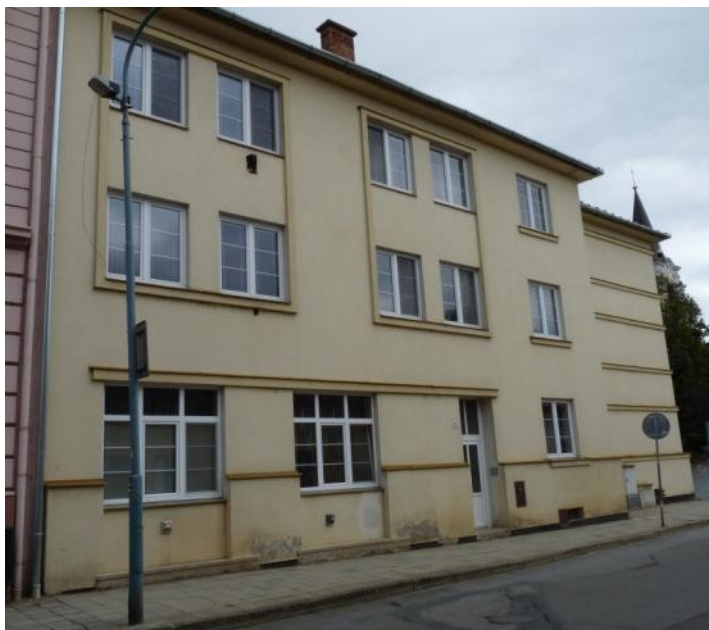
Obrázek č. 43: Dům č. p. 79, současný stav.
