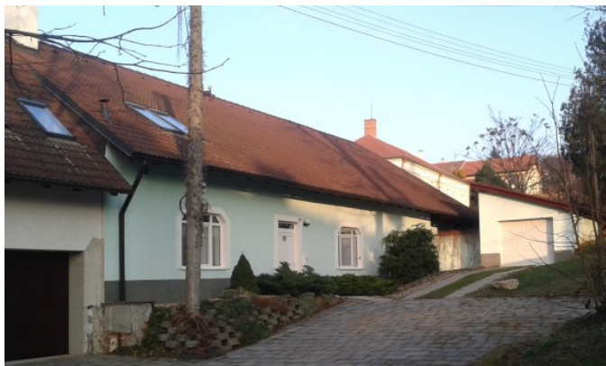
Obrázek č. 58: Dům č. p. 83, současný stav.
