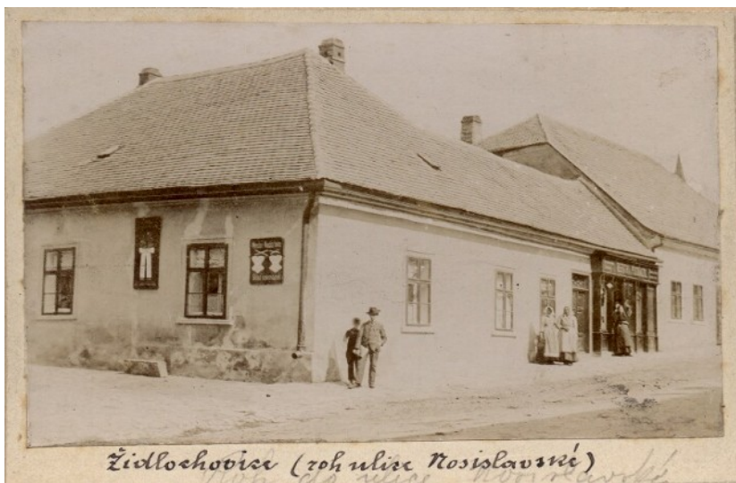
Obrázek č. 68: Dům č. p. 85, stav mezi lety 1900 až 1920. 147
