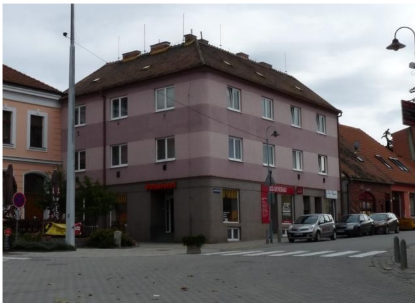
Obrázek č. 67: Dům č. p. 85, současný stav.
