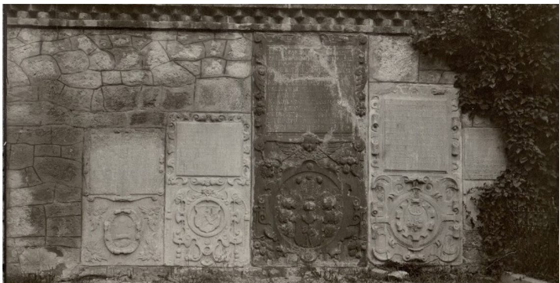
Obrázek č. 7: Jižní strana zvonice se zazděnými náhrobky. 38
