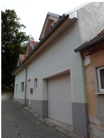
Obrázek č. 95: Dům č. p. 917, současný stav.
