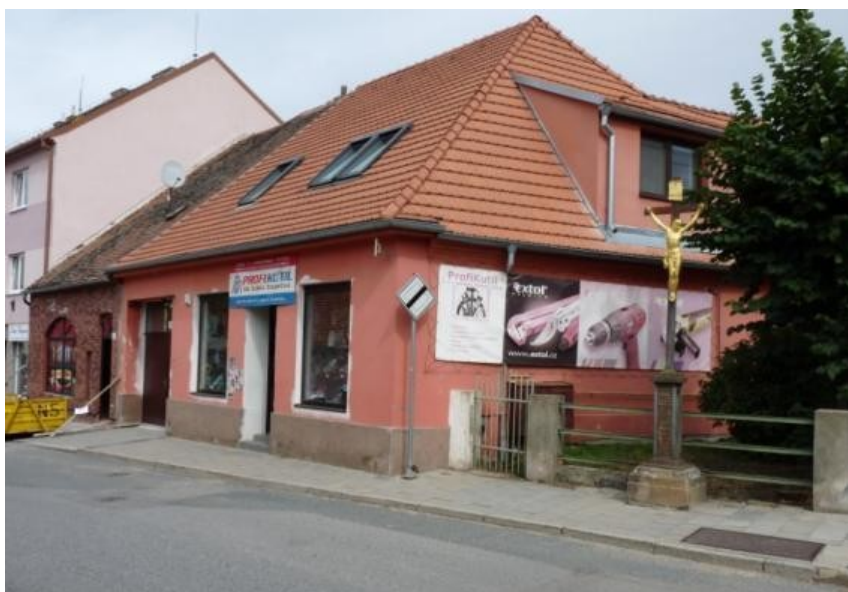
Obrázek č. 62: Dům č. p. 84, současný stav.
