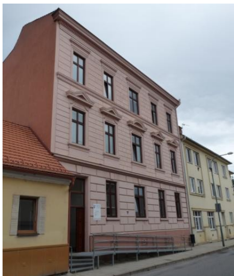
Obrázek č. 47: Dům č. p. 80, současný stav.
