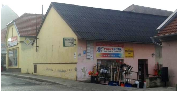
Obrázek č. 40: Dům č. p. 57, současný stav.
