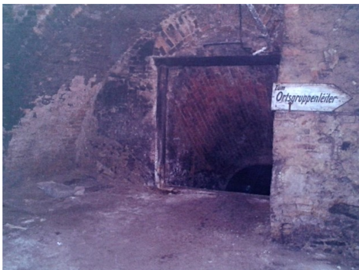
Obrázek č. 16: Vchod do sklepa domu č. p. 32.
