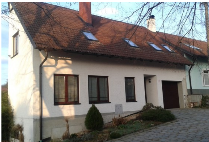
Obrázek č. 94: Dům č. p. 727, současný stav.
