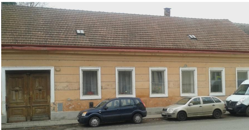
Obrázek č. 29: Dům č. p. 37, současný stav.
