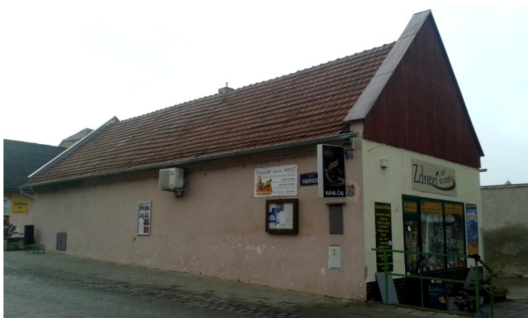
Obrázek č. 10: Dům č. p. 31, současný stav.
