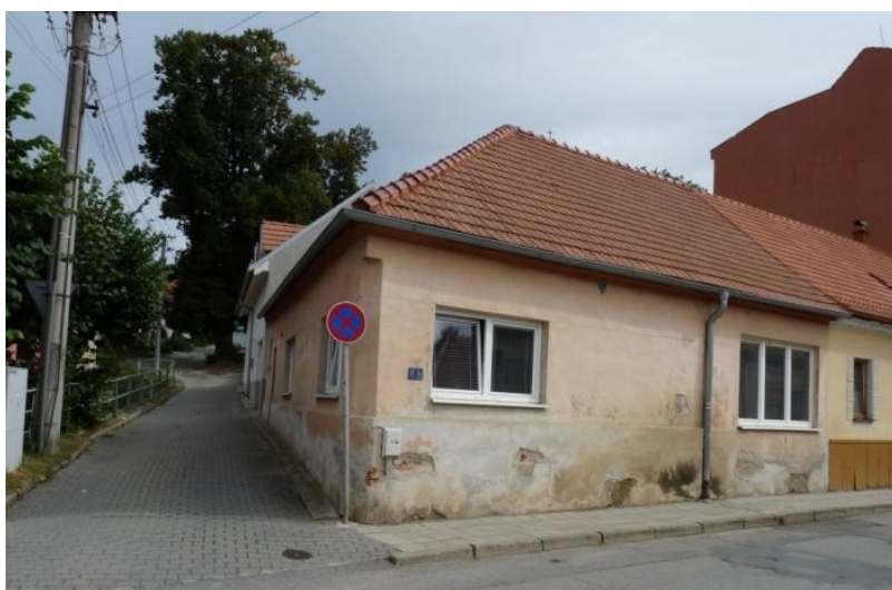
Obrázek č. 50: Dům č. p. 81, současný stav.
