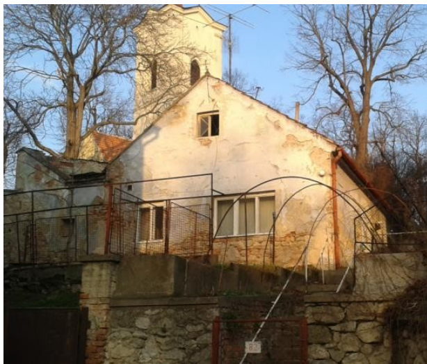
Obrázek č. 54: Dům č. p. 82, současný stav.
