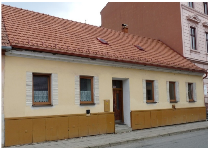
Obrázek č. 86: Dům č. p. 395, současný stav.
