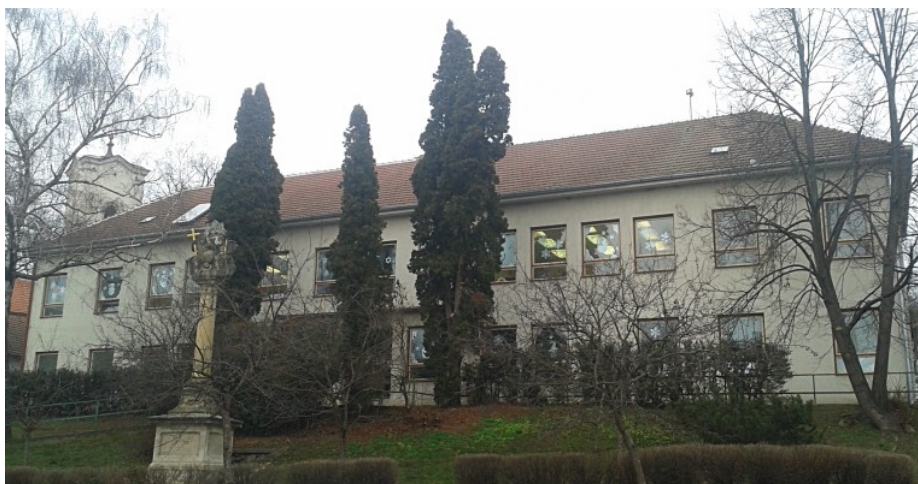
Obrázek č. 78: Dům č. p. 182, současný stav.
