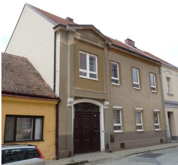
Obrázek č. 22: Dům č. p. 35, současný stav.
