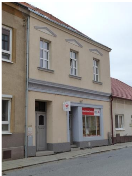
Obrázek č. 92: Dům č. p. 458, současný stav.
