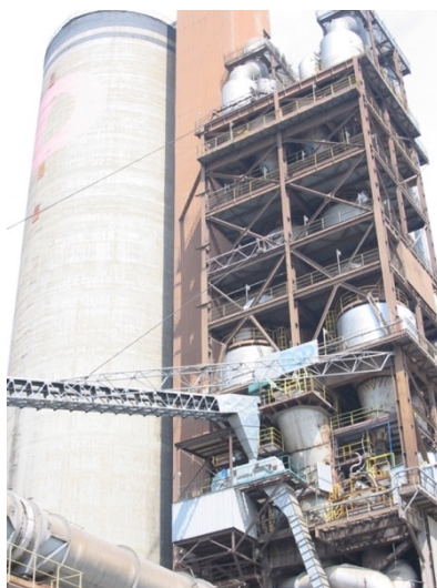
Obrázek 5. Čtyřstupňový předeheřivač typu Humboldt; Českomoravský cement a.s., závod Mokrá
