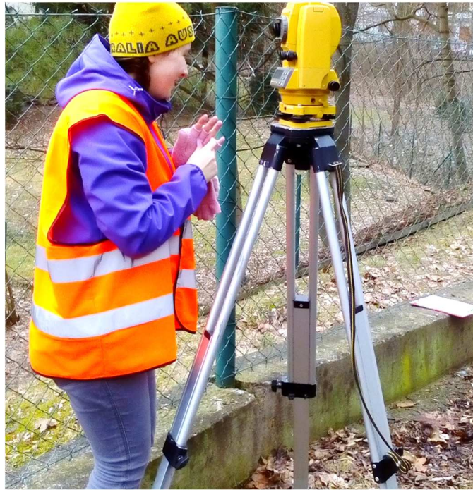
Obr. 7 Příprava totální stanice Topcon GTS k měření kontrolních bodů
