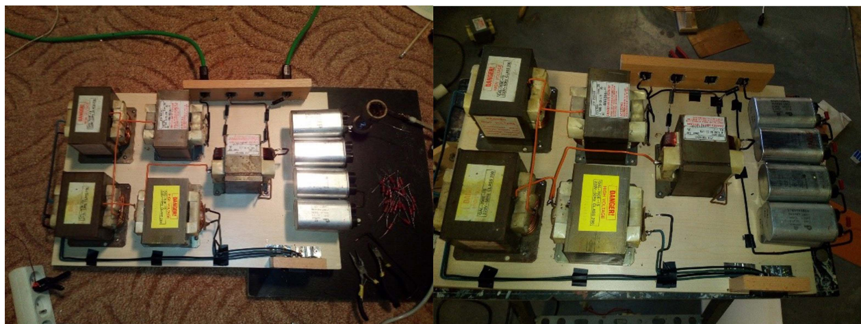
Obrázek 4.43: Stavba vysokonapětového zdroje.
