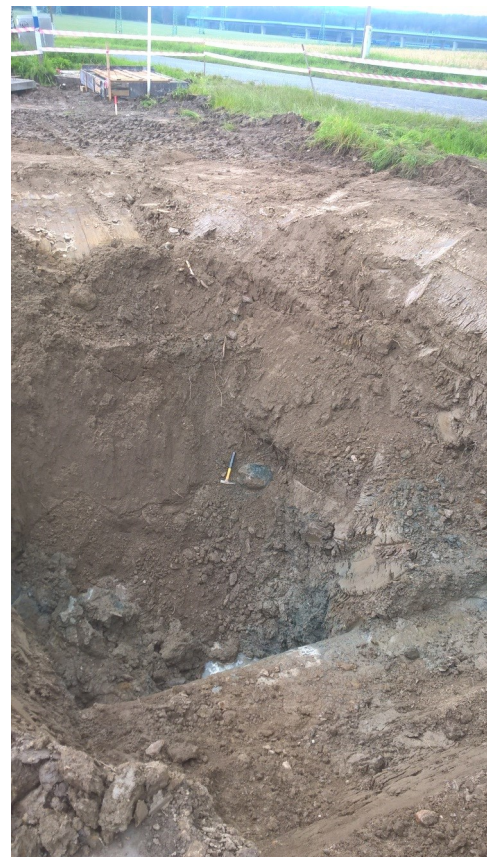
Obr. 15: Výkopy na Vírtoých pegmatitech.
