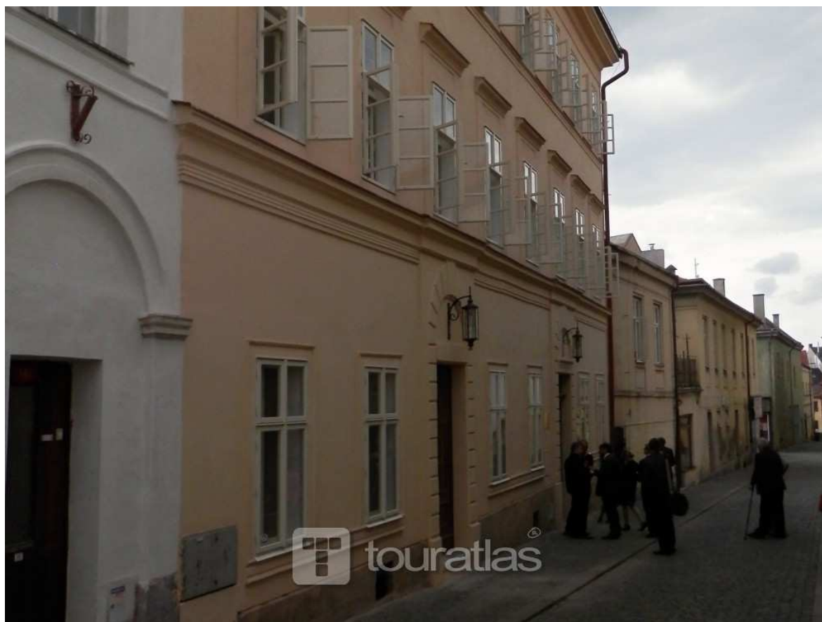
Obrázek č. 11: Současný stav budovy bývalé židovské školy v Jičíně
