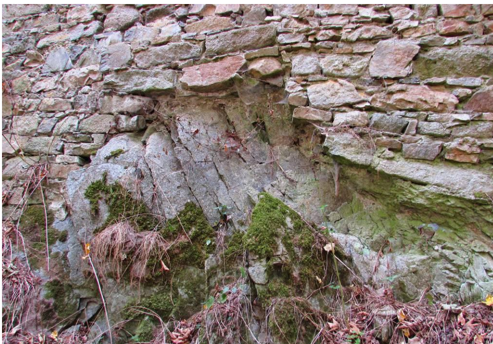
Obr. 10 Porfyrový výchoz pod hradební zdí, struktura skály je narušena zlomem, který vznikl již po utužení žíly
