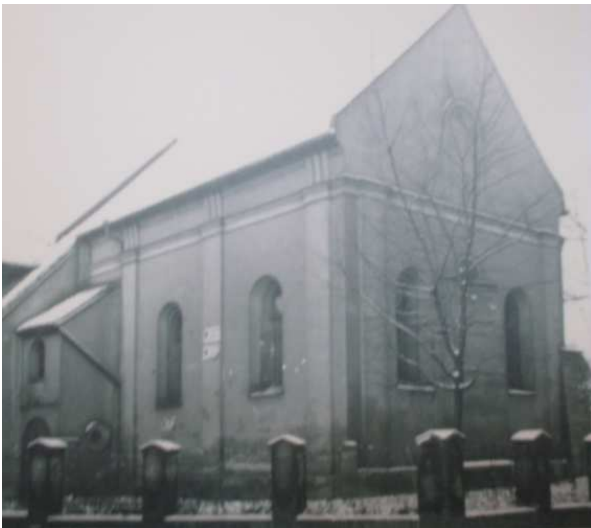
Obrázek č. 14: Exteriér jičínské synagogy v roce 1942
