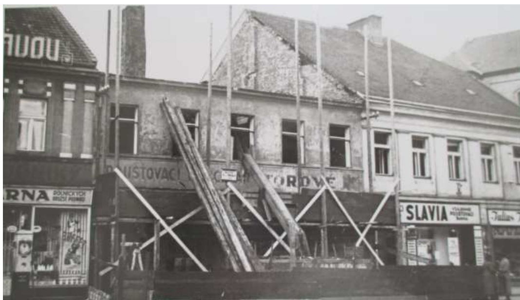
Obrázek č. 39: Proces bourání domu č. p. 6 Žižkovo náměstí patřícího rodině Steinerových (dříve rodině Kantorových). V roce 1938 byl na tomtéž místě postaven nový obchodní a rodinný dům.
