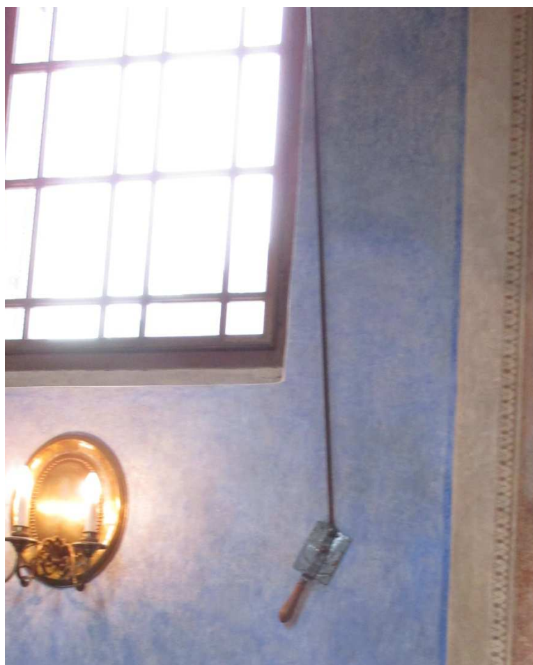
Obrázek č. 18: Dodnes dochovaný původní mechanismus na otevírání oken v jičínské synagoze
