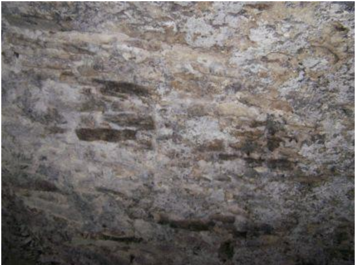
Obr. 9 Kombinace kamenného a cihelného zdiva ve sklepě, klenba sklepa
