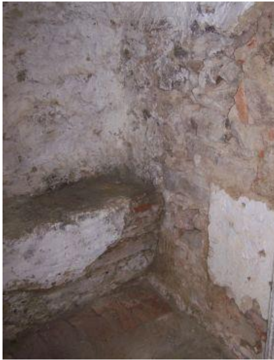
Obr. 10 Pozůstatek po odstraněné klenbě sklepa
