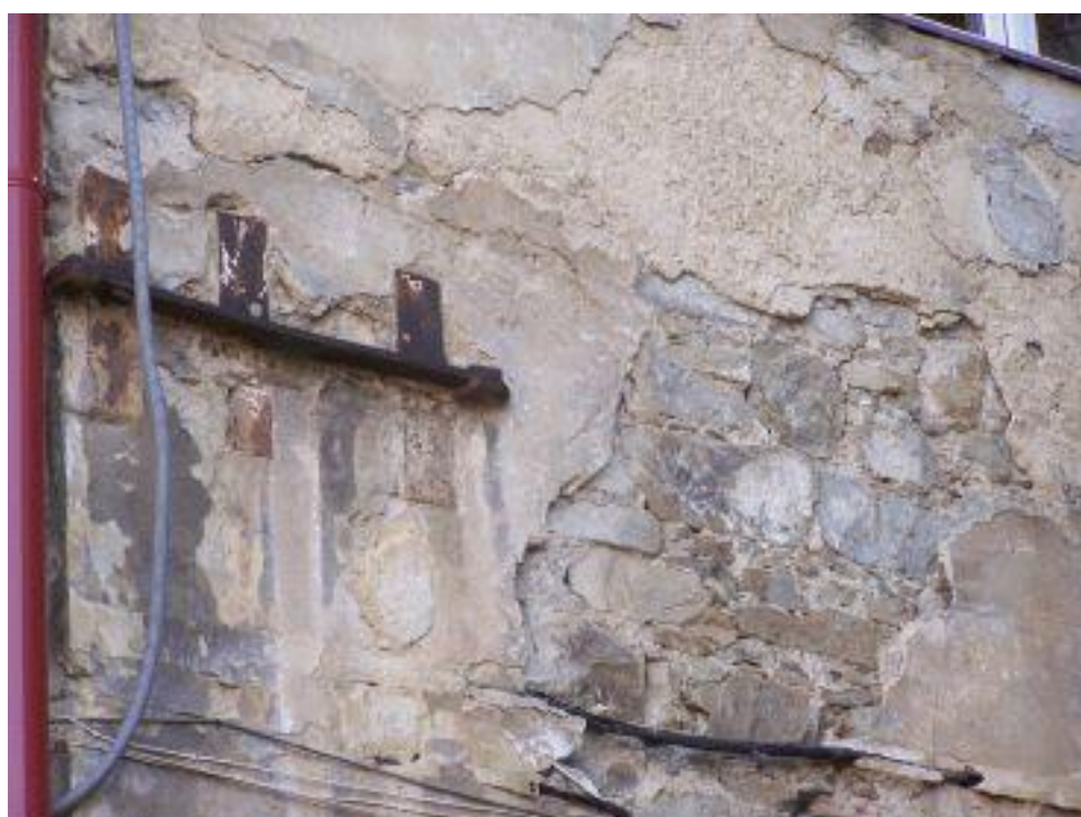
Obr. 8 Kamenné zdivo na schodech na půdu a obvodové zdivo z Uprkovy ulice s kleštinami
