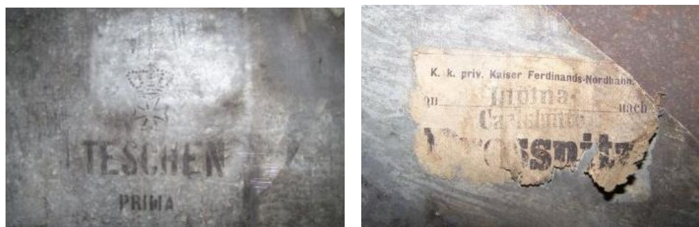
Obr. 15 Označení plechu střechy a jeho přepravní lístek z vlaku
