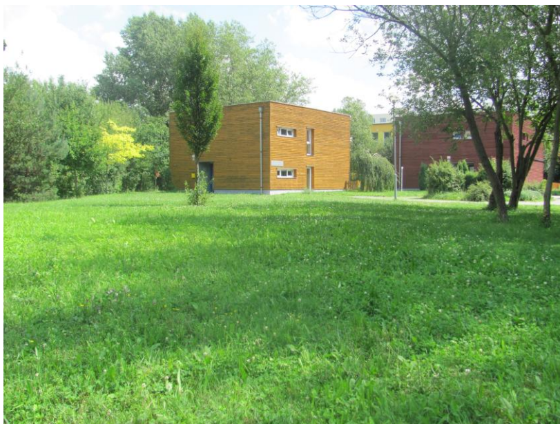
Obrázek 17: Fotografie původního stavu vesničky č.1
