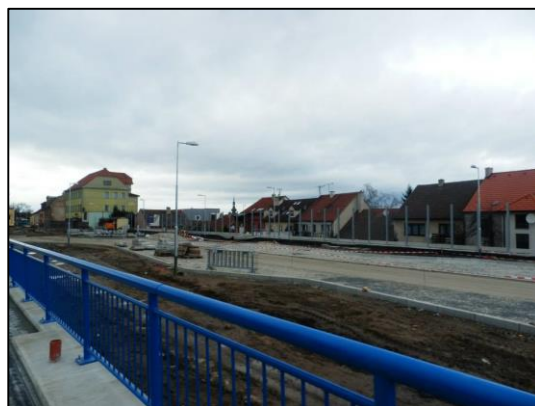
Obr. 8.2 Fotografie dokumentující průběh stavebních prací na dopravním terminálu (stav k 22. 12. 2014)
