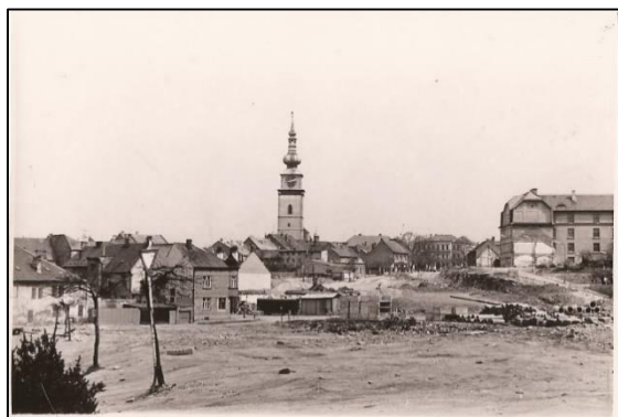
Obr. 5.1 Fotografie dokumentující stavbu nového autobusového nádraží
