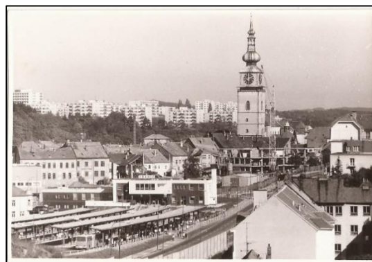
Obr. 5.2 Pohled na dokončené autobusové nádraží v Třebíči
