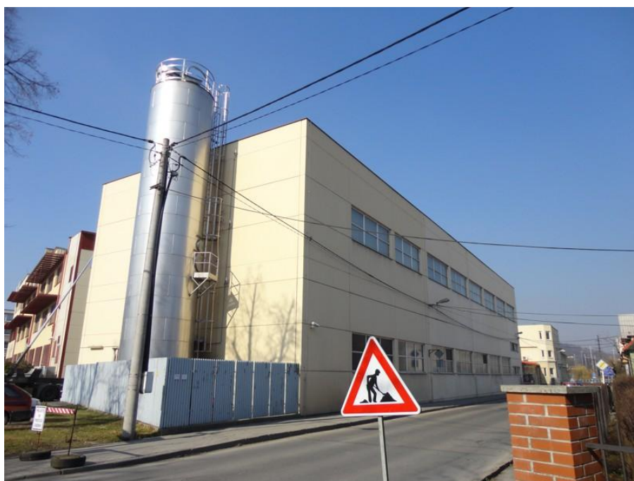
Obrázek 14: Současná podoba tovární budovy s moderní přístavbou, z pohledu od ulice Palackého.
