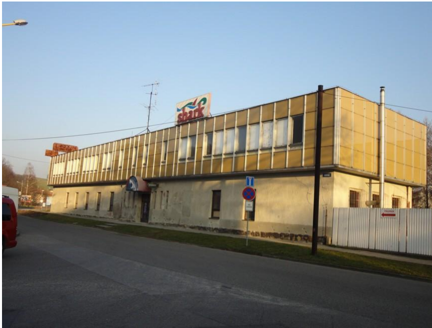
Obrázek 19: Dnešní stav závodního klubu, původní jsou jen základy budovy
