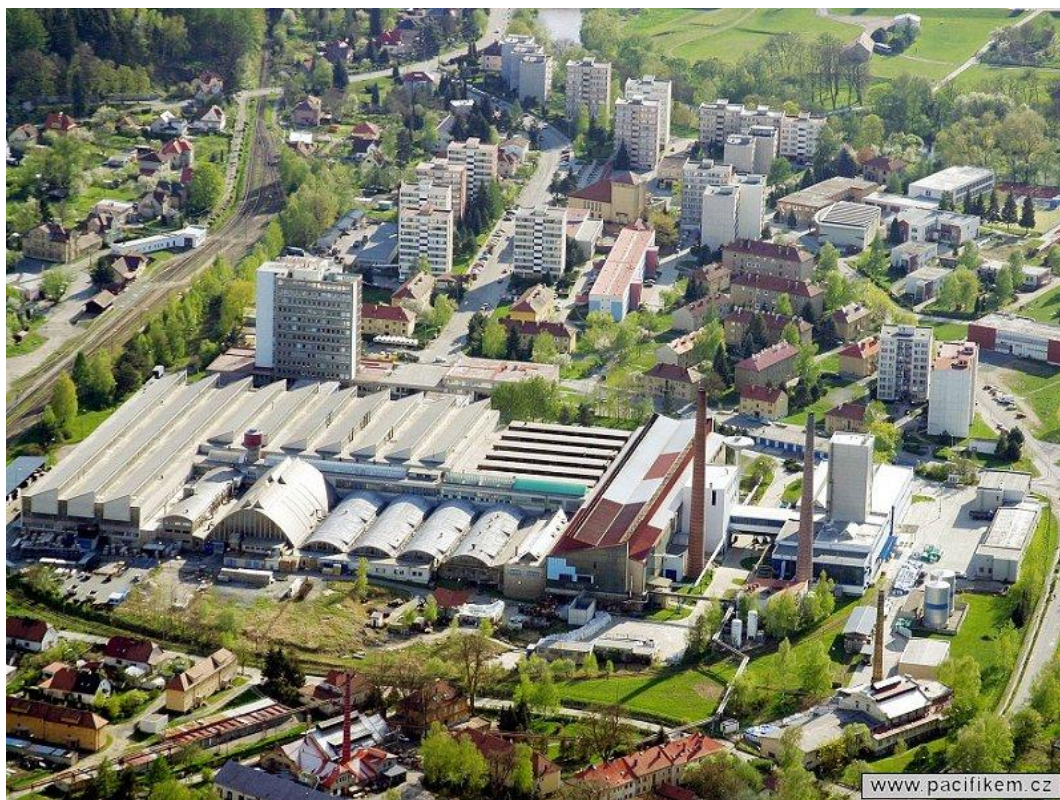
Obrázek 26: Parabolická budova továrny v Sázavě nad Sázavou
