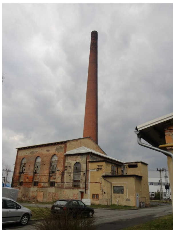
Obrázek 50: Současný stav původní budovy kotelny s komínem
