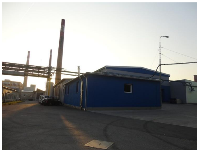
Obrázek 22: Rekonstruovaná hutní hala č. 2
