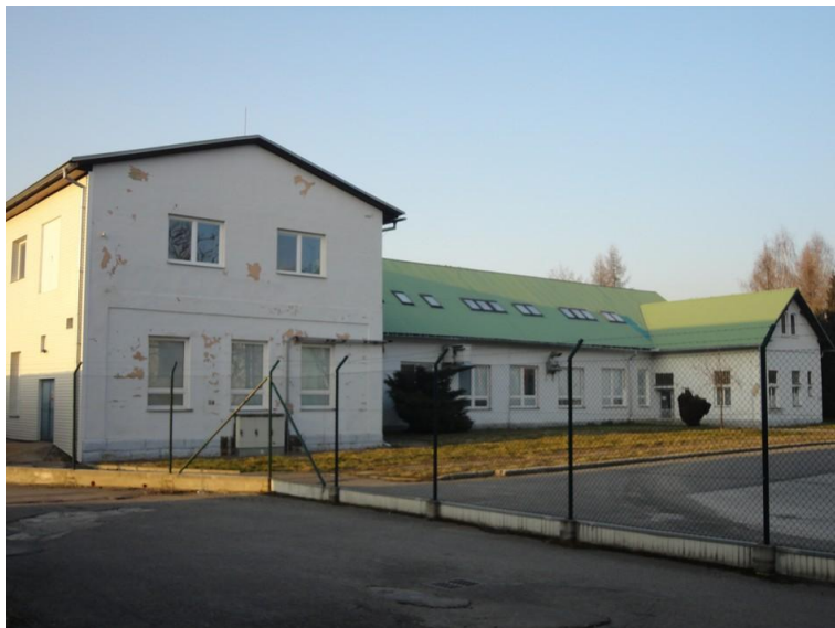
Obrázek 20: Současný stav budov bývalých malíren
