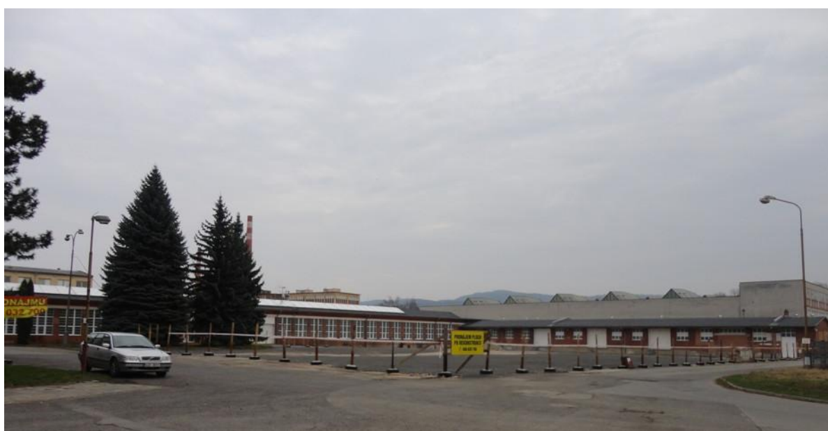
Obrázek 34: Areál bývalé firmy Mikroфона a později Tesla. Do dnešních dní se dochovaly pouze budovy pomocných provozů, budova vlastní továrny byla v nedávné době zbourána. Stála zhruba uprostřed, mezi budovami, které vidíme na fotografii. Vypadala přibližně tak, jak je namalována na obrázku 31 výše.
