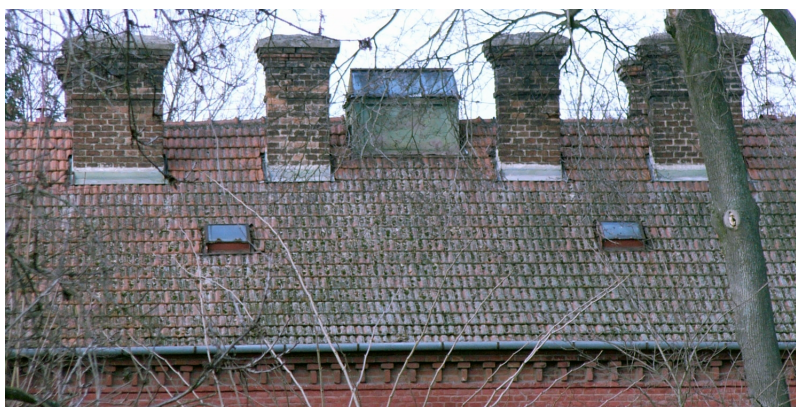
Obrázek 27: Stávající střešní okna
