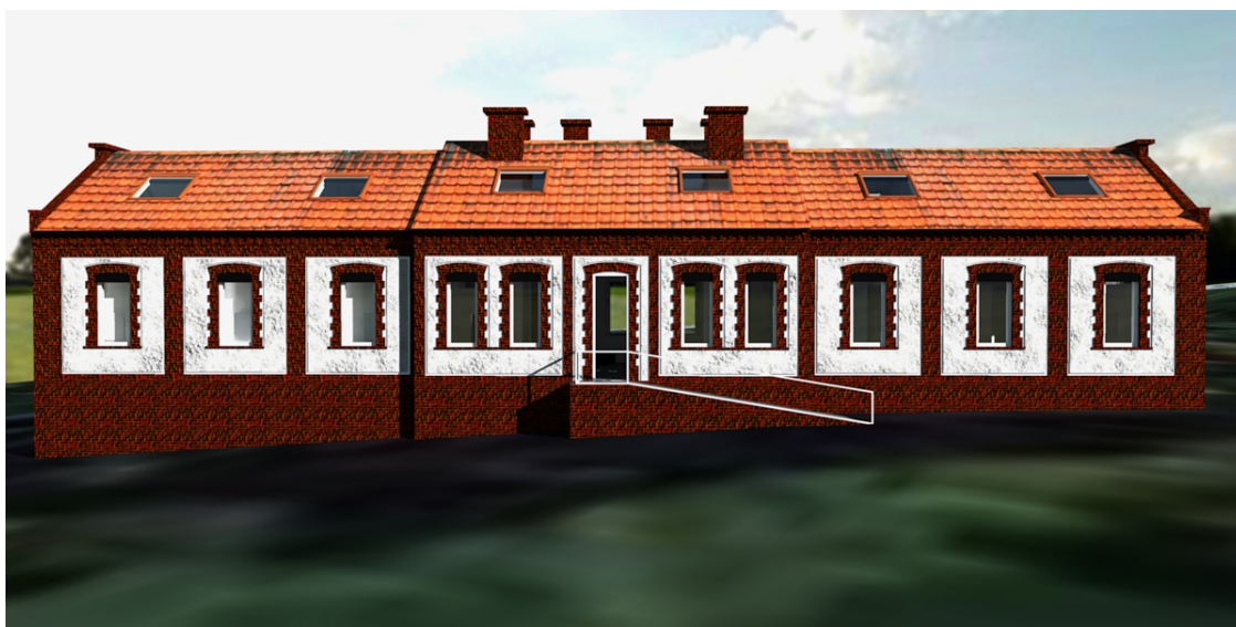
Obrázek 17: Exteriér - pohled ze severu
