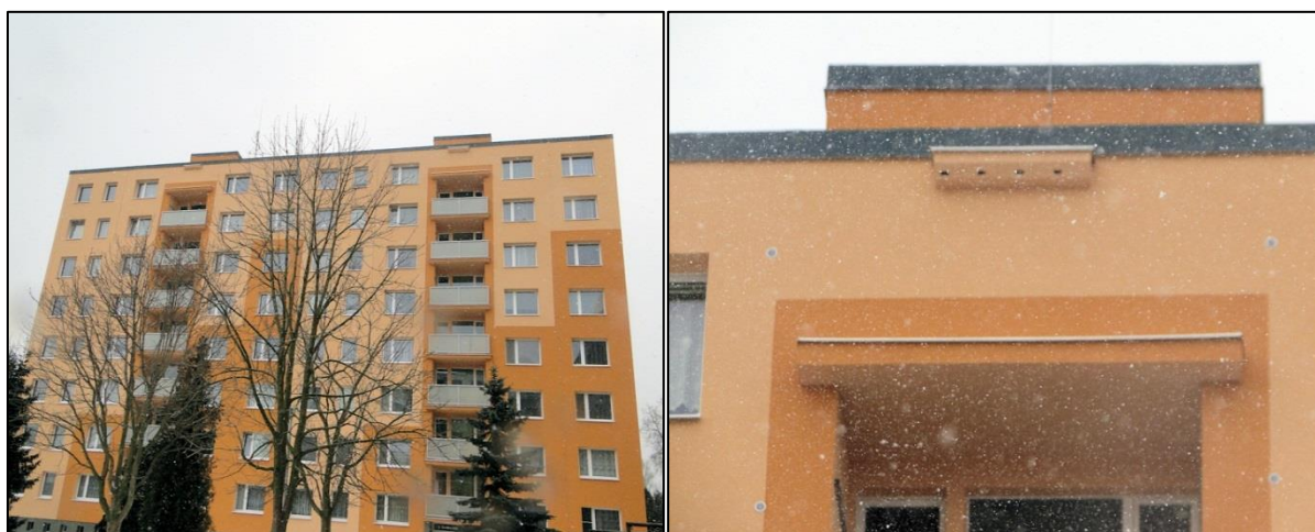
Obr. 7: Netopýřní budky instalované na zateplené fasádě na domu čp. 685/686 v Blovicích
