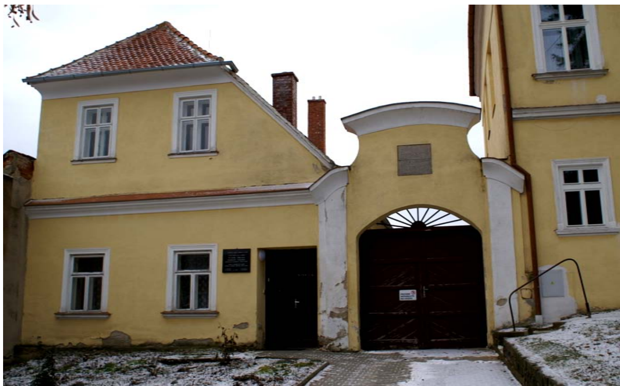
Obr. 26 Bývalá farská konírna upravená jako byt pro varhaníka
