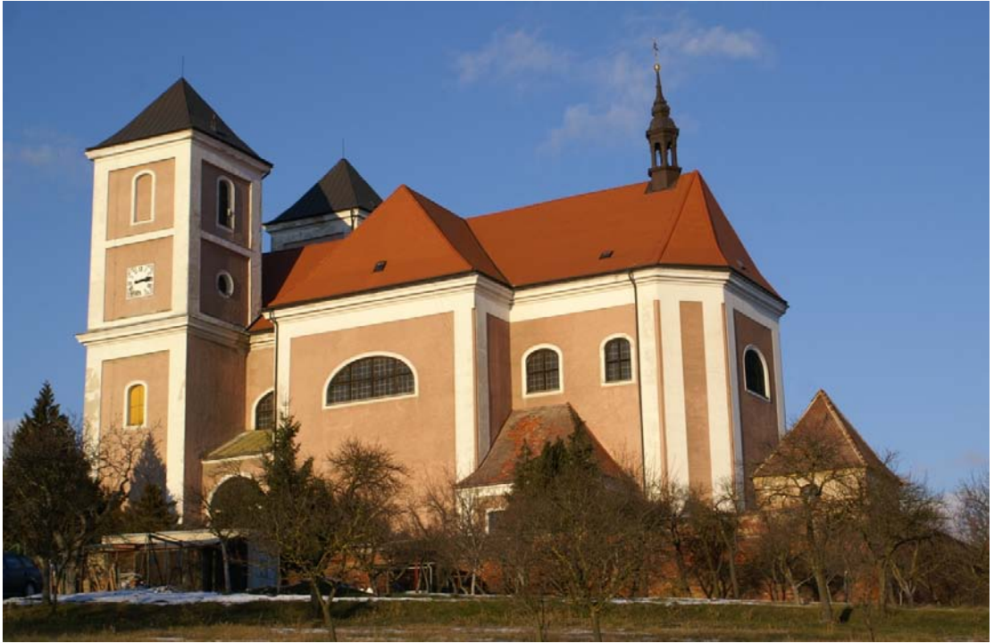
Obr. 8 Pohled na pozoříčský kostel Nanebevzetí Panny Marie od jihozápadu
