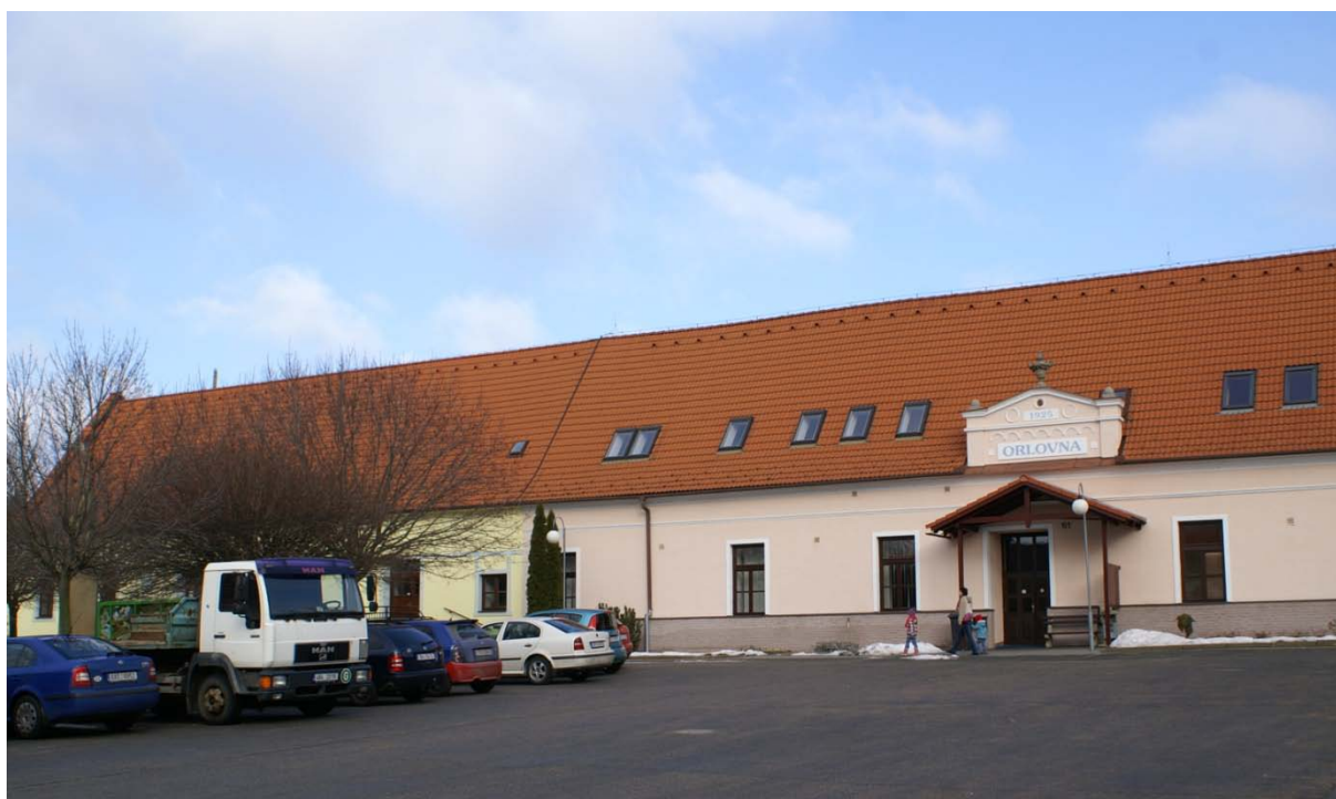
Obr. 30 Bývalý byt šafáře a přípravná krmiv, dnes budova Orlovny
