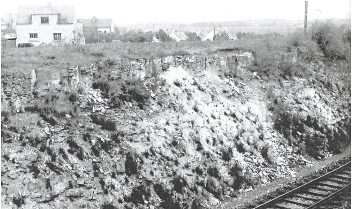
Obr. 1 Zářez libochovické trati po jihozápadní straně Černčic. Svrchu patrná 1m mocná vrstva řasáku IVb, pod ním v zářezu kallianassový pískovec IVa (foto M. Váně 1944).
