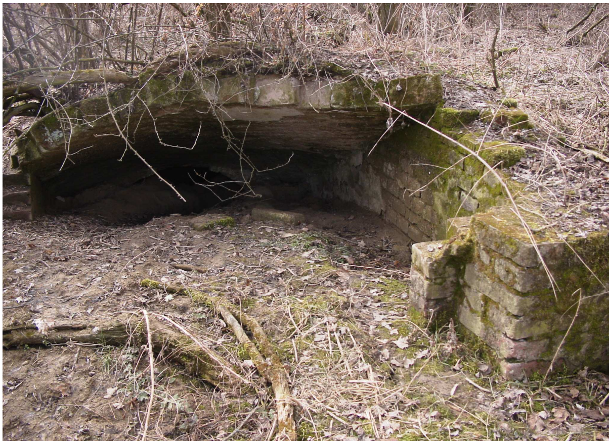
Obrázek 48: Stav „Vinného“ sklepa v roce 2003 / Zdroj: Archiv autora
