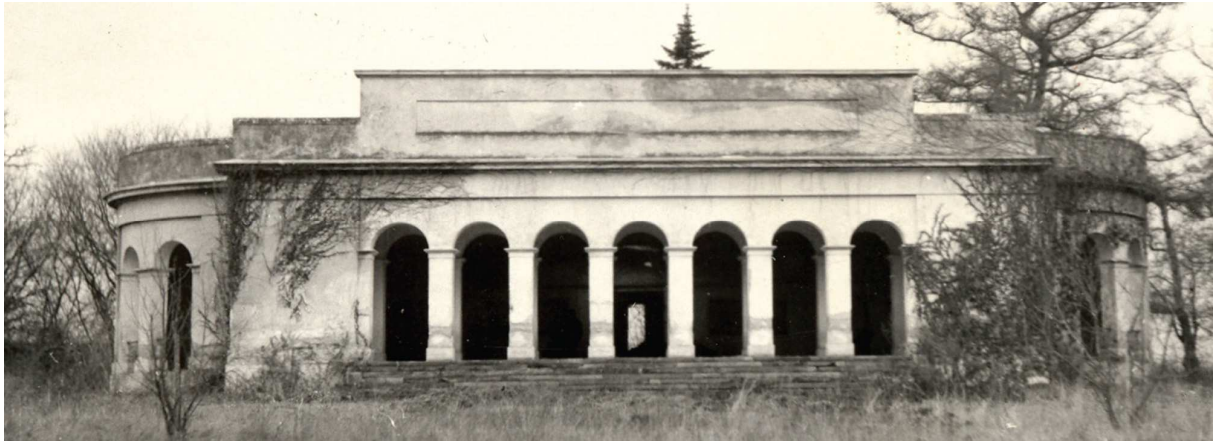
Obrázek 6: Katzelsdorfský zámek v roce 1956 - průčelí / Zdroj: Archiv památkového ústavu Brno
