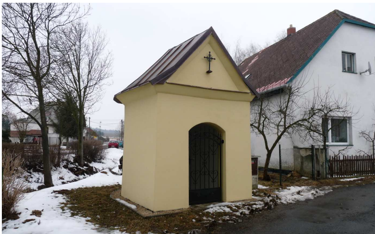
Příloha č. 24: Opravená kaplička v Radiměři u č. p. 121. Foto: Matěj Kmošek, 2012.
