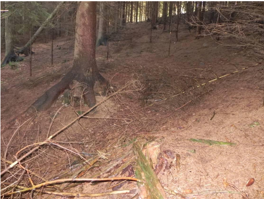
Obr. 20: Zasuté ústí štoly na levé straně Zlatého potoka
