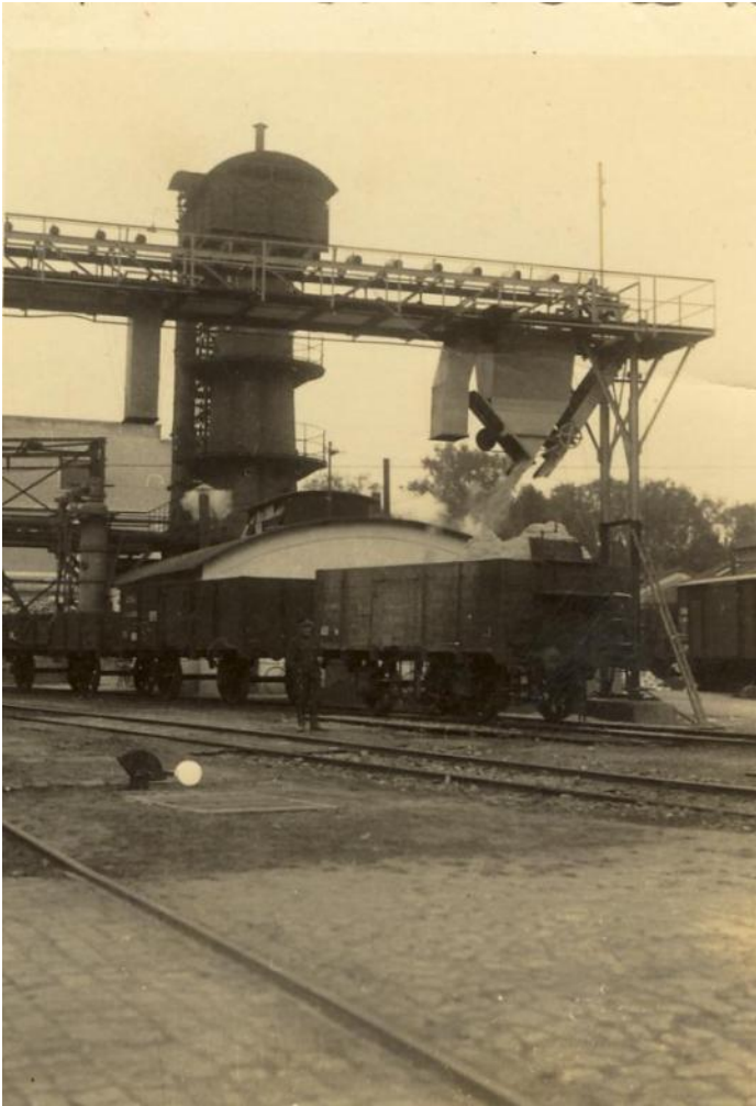
Obrázek 18.: Nakládka železných nákladních vozů pomocí pásového dopravníku a speciálního sypáče, nedatováno, pravděpodobně 30. léta 20. století. Zdroj: PA TTD.
