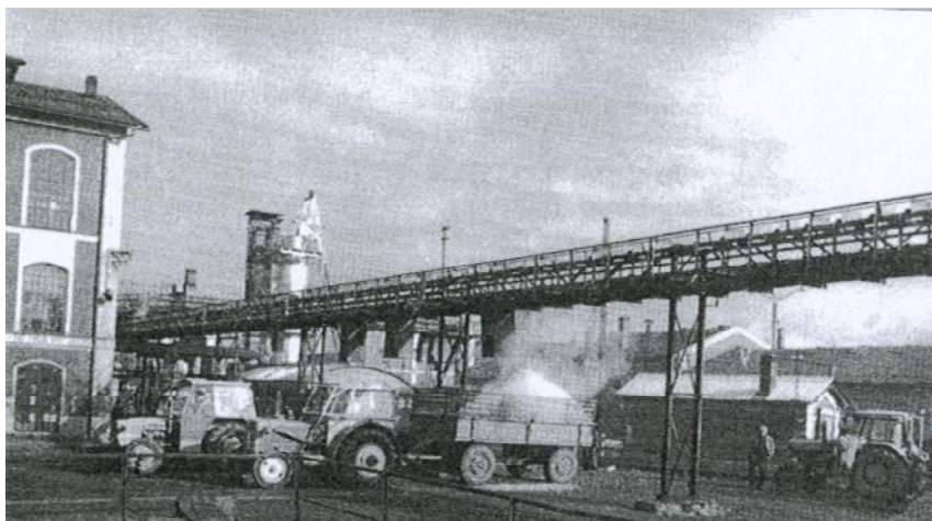
Obrázek 20.: Dvojice traktorů, do nichž probíhá nakládka uhlí, a zatím traktor stojící u vlečkových kolejí v pozadí dokládají postupný úpadek přepravy po železnici, 1958. Zdroj: PA TTD.
