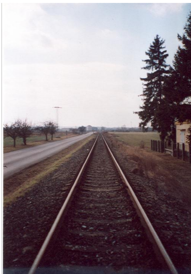
Obrázek 34.: V nejdél-ím, více neff kilometrovém p ímém úseku vle ka p ekonává vzdálenost mezi nádrafím a okrajem m sta Dobrovice. Úpln vpravo stojí mezi stromy budova artézské studny z let 1946-1947 (plán k její stavb viz obr. 8.), 9. 2. 2009. Foto: autor.
