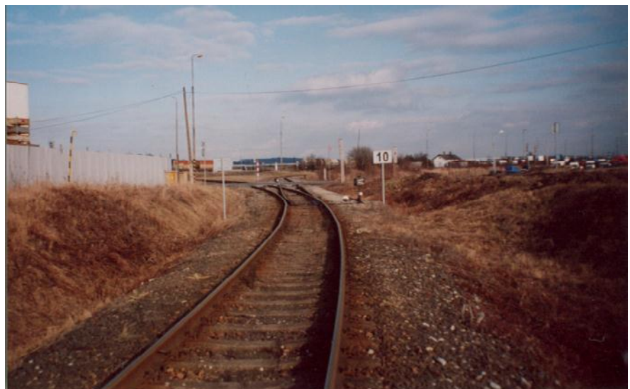
Obrázek 40.: Převodní cukrovarská kolej stoupá mezi sílem a zahradami afluentsilnice do Kosoúhelníkové. Blízkost přímky dává tušit nejdříve trojúhelníkovou návěst upozorující na omezení rychlosti a zcela vzadu červenobílý špičkový ekod, odložené kolejnice prozrazují nedávné opravy 9. 2. 2009. Foto: autor.
