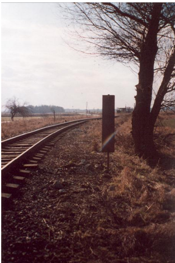
Obrázek 31.: Fotografie nyní již prorezivělé návěstí, která dříve upozorovala strojvedoucí na vjezdové návěstidlo umístěné vlevo ve směru jízdy, 9. 2. 2009. Foto: autor.
