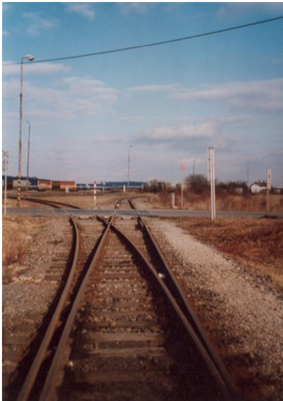
Obrázek 42.: Rovněž před jezdem se odděluje krátká spojka vedoucí přímo do areálu bývalé stanice Dobrovice m. st. Jde o oněch pověstných 200 metrů, které zbývaly ke spojení obou dobrovických nádraží pro osobní dopravu., ale postaveny byly flezbním vojskem až v době zastavení osobní dopravy na trati Dobrovice m. st. - Dětnice. V místech vlevo od kolejí stávalo od podzimu 1944 do května 1945 provizorní nástupiště pro vlaky z trati Mladá Boleslav - Nymburk zajišťující na vleku, 9. 2. 2009.
