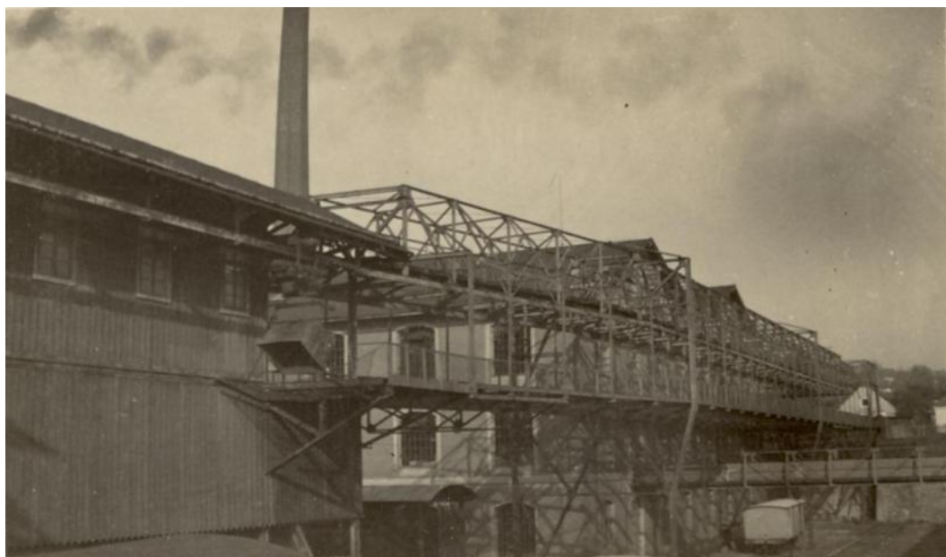
Obrázek 17.: Je to jeden pohled na zakončení vlečky u rafinerie, v popředí je velice dobře patrný dopravní most na řízky, nedatováno, pravděpodobně 30. léta 20. století. Zdroj: PA TTD.
