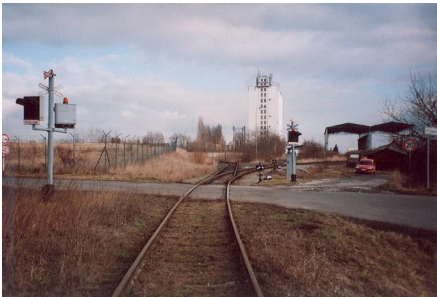
Obrázek 35.: P ímý úsek kon í u jediného p ejezdu na vle ce zabezpe eného sv telnou signalizací, jímfl koleje k íflí silnici z Libichova. V pozadí krom budovy sila spoje nosti Zena zaujmou i odbo ky do zmín ného sila a k areálu spoje nosti Schnellecke, zhruba v t chto místech do roku 1953 existovala kolej do cihelny, 9. 2. 2009. Foto: autor.
