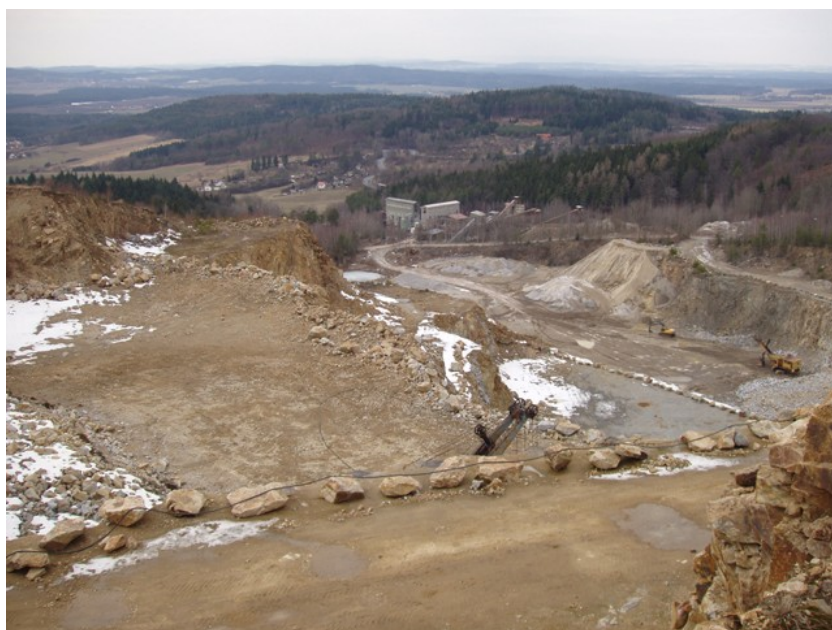
Obr. č. 34: Lom Kamenné doly, pohled z vrchních etází lomu sz. směrem (foto: březen 2010).
