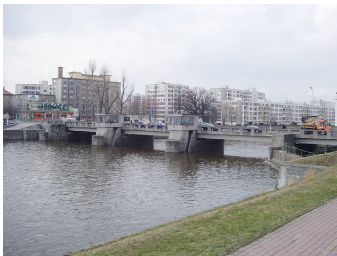
Obr. č. 30: Nový most přes řeku Otavu v Písku (foto: březen 2010).
