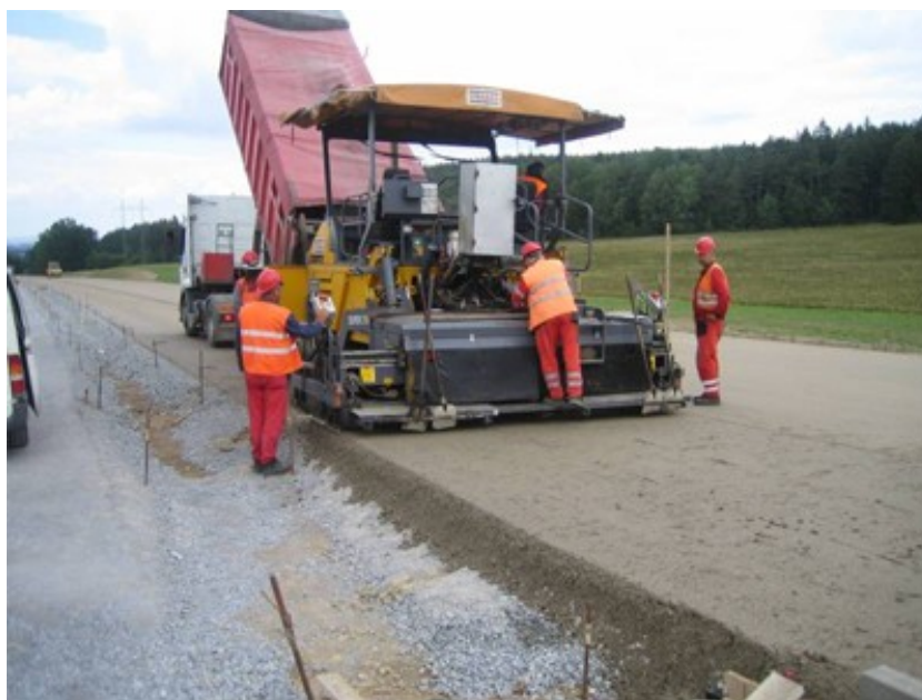
Obr. č. 36: Při realizaci úseku silnice I/4 (Křižovatka Nová Hospoda) v l. 2006 - 2007 bylo firmou Strabag a.s. záv. Písek využito dodávek MZK frakce 0/32 (směs drceného kameniva o zrnitosti od 0 do 32 mm) z lomu Kamenné doly 16 .
