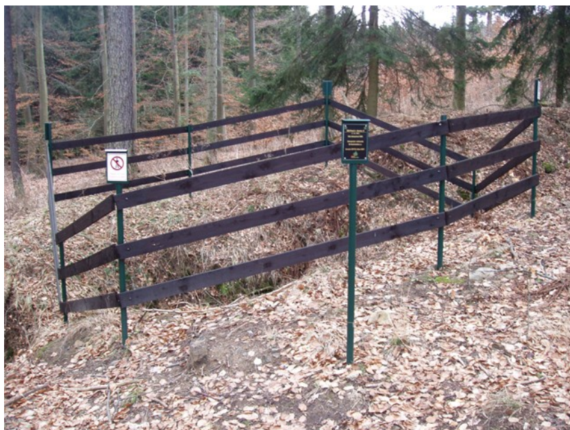
Obr. č. 14: Zabezpečení při poddolovaných místech v řadách šachet na Havírkách realizovala firma SG-Geotechnika a.s. za investice MŽP ČR (foto: březen 2010).
