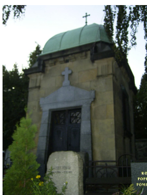
Hřbitovní kaple, objekt č. 107
