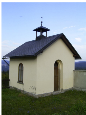
Hřbitovní kaple, objekt č. 55
