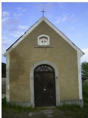
Hřbitovní kaple, objekt č. 56
