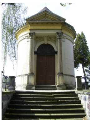
Hřbitovní kaple, objekt č. 106
