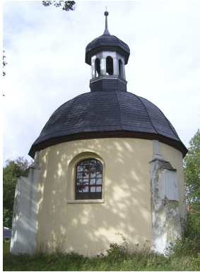
Kaple navštívení Panny Marie, objekt č. 41
