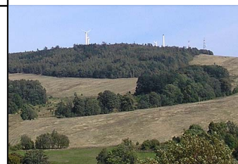
Větrné elektrárny v Albrechticích
