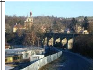
Železniční viadukt v Rychnově
